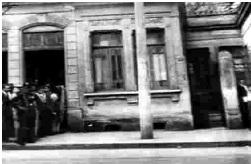
Fachada da casa – Rua Santo Antônio 104.
