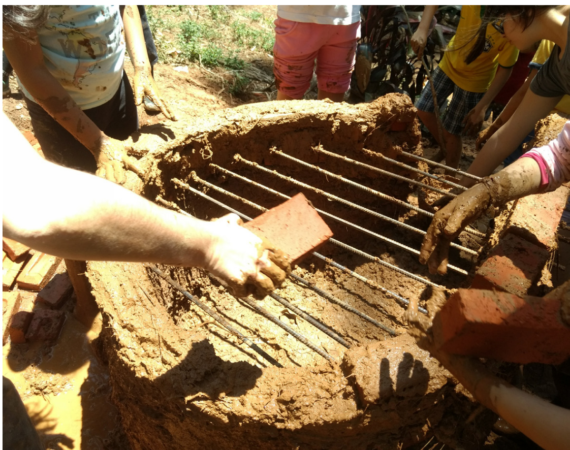
Figuras 9 e 10. Alunos construindo forno para queimar peças de argila. Fonte: Cintia Valente
