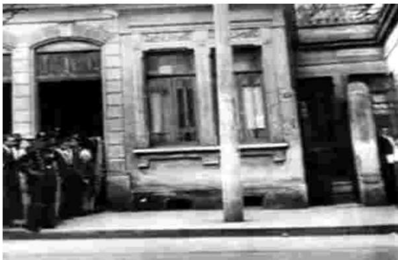
Figura 3. Fachada da casa na Rua Santo Antônio, no. 104
