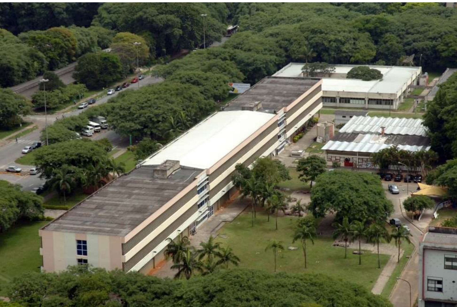
Figura 16 - O prédio central da ECA e, ao fundo, o Bloco A, o prédio do Jornalismo. O Bloco C era uma construção muito parecida, e com a saída das Artes Cênicas para o novo prédio, foi totalmente reformado e hoje é o Departamento de Cinema, Rádio e Televisão, o CTR.
