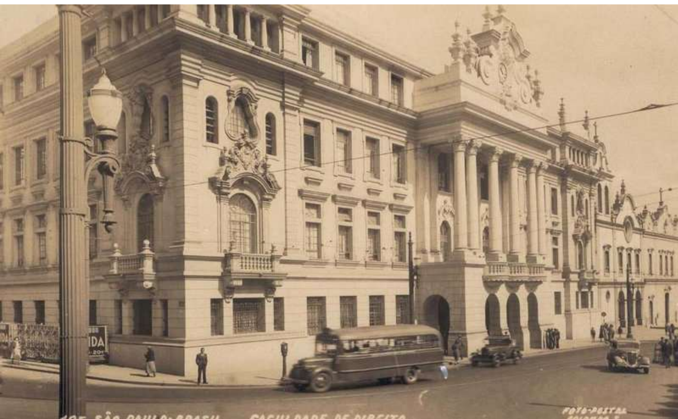
Figura 1- O prédio da Faculdade de Direito, na década de 1940. Fonte: Wikicommons.
