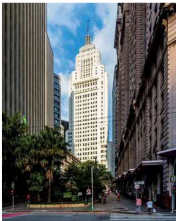
Figura 4 - Edifício Altino Arantes
